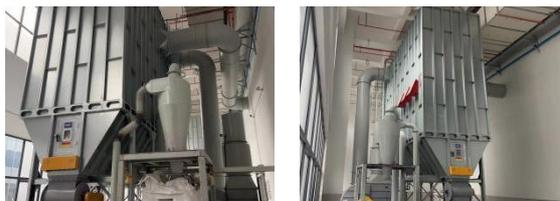
开槽工序脉冲式布袋除尘器
