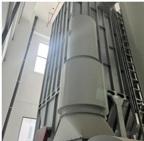
多片锯工序脉冲式布袋除尘器
