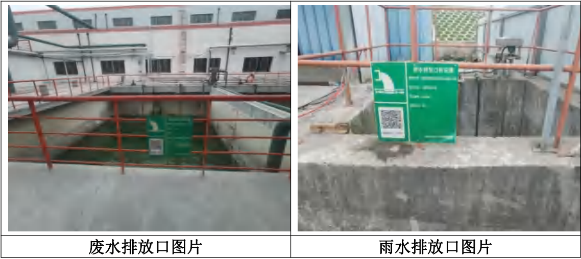
图 4.1-1 废水、雨水排放口图片
